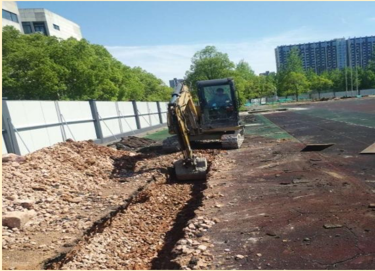
👉 室外管沟开挖施工。
