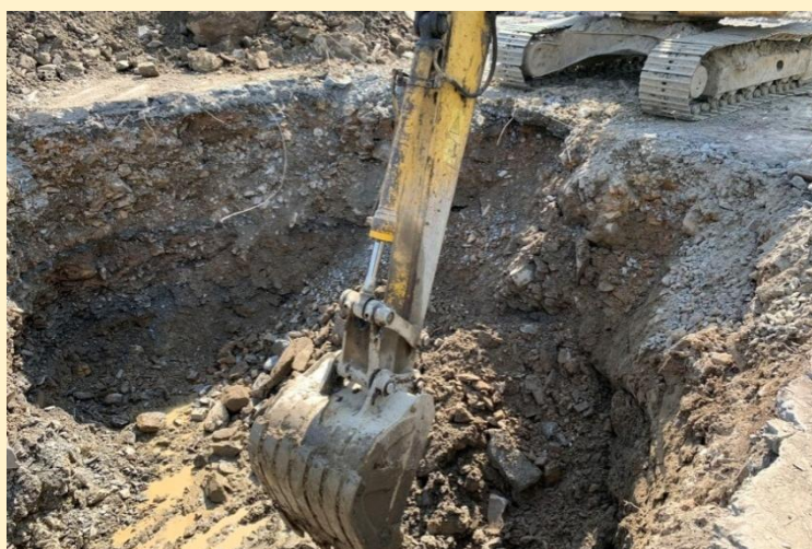
📷 安检备勤用房 (赛时临时媒体区) 钢膜结构临时建筑 基础部分基坑开挖。
