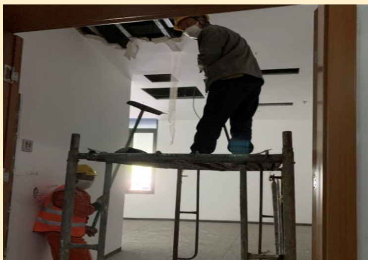
📷 文体中心主馆副 馆室内设备、墙体、 吊顶拆除及地坪凿 除等。
