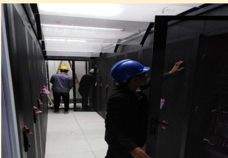
网络中心机房智能化机柜控制系统线熔接。
