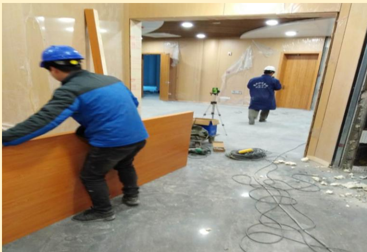
主、副馆木门及防火门安装。
