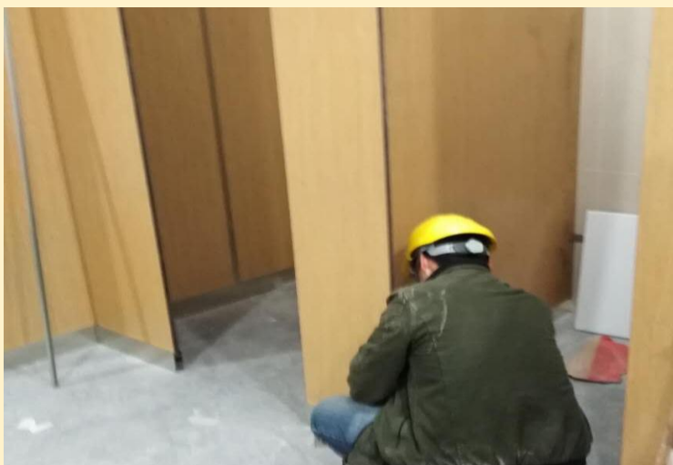
卫生间抗倍特板隔断安装。
