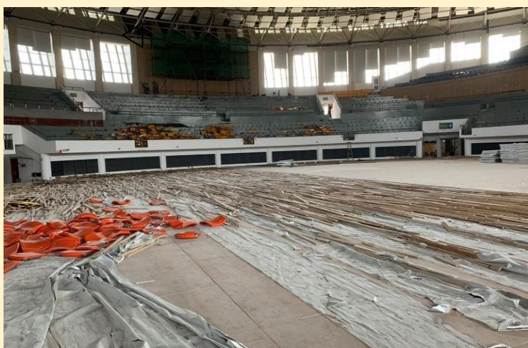
📷 主馆内运动木地板及看台座椅拆除。
