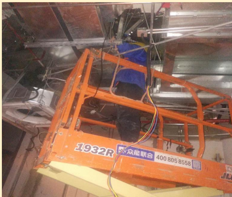
📷 文体中心主馆桥架内网络线，门禁线等敷设。
